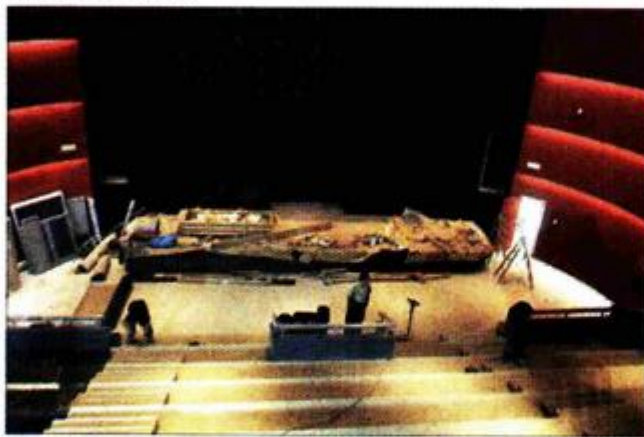
Završna faza uređenja kinodvorane - nedostaju stolice i platno
